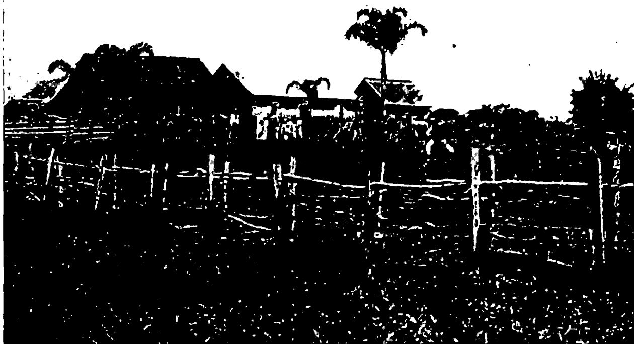
Colonie italienne. appartenant à M. Venceslao Billo di Arcole (Vérone), située dans l'ensemble colonial « Nova Venezia » (Etat de Santa Caterina).
